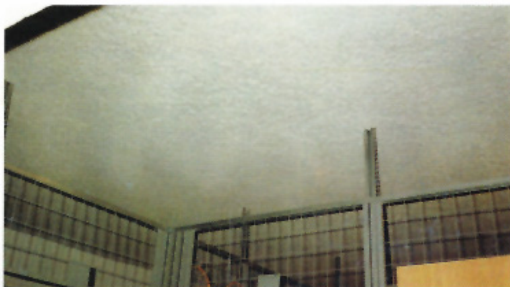
Kellerdeckendämmung mit Dossolan Thermique - Rauputzstruktur -
