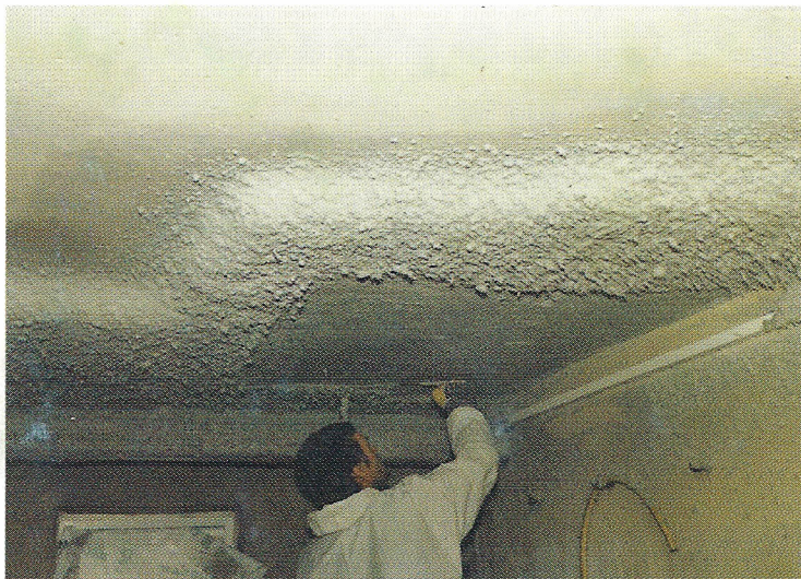
Oberflächengestaltung durch Andrücken der Dämmschicht.
