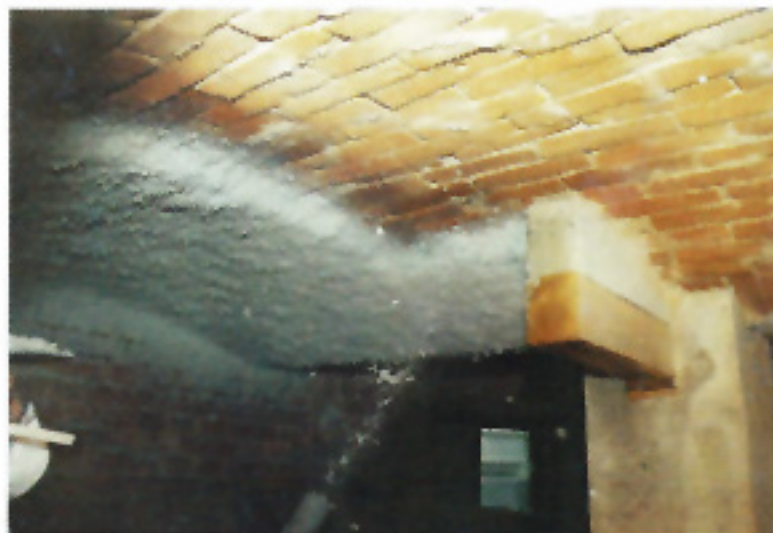
Aufspritzen der Dämmschicht an einer Gewölbedecke
